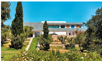
La fondation Carmignac - Ile de Porquerolles ©D.R
