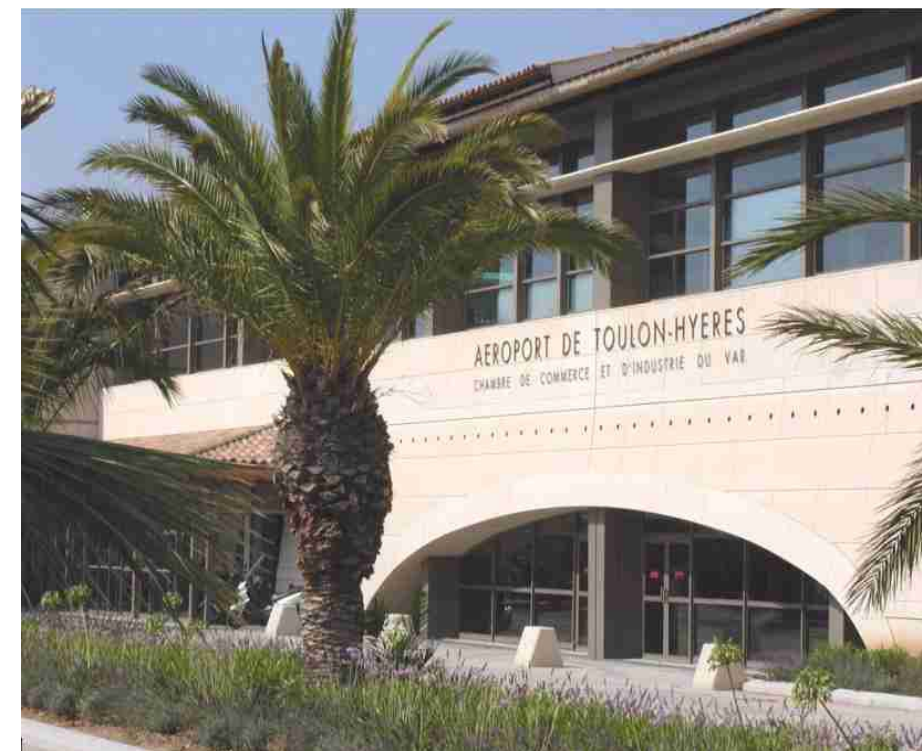
En zone est : les installations civiles
