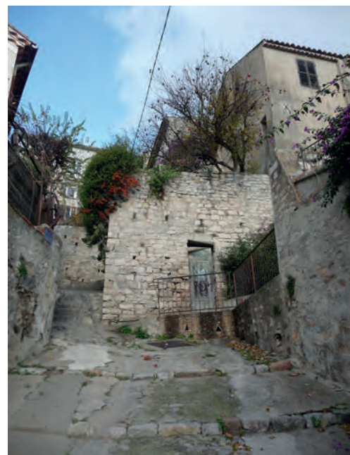
Murs et soutènements de jardins
